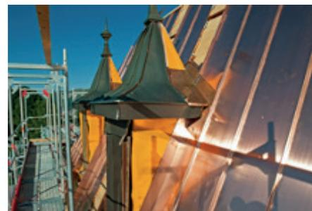
Aufgrund der Auflagen der kantonalen Denkmalpflege musste das neue Dach wieder mit Kupfer eingedeckt werden. 6,5 Tonnen Kupfer waren dazu notwendig. Das verwendete Kupfer erfüllt alle wichtigen und strengen europäischen Normen. Das zurückgebaute Kupfer wird ausserdem recyclet und findet seine Wiederverwendung, so dass kein neues Kupfer abgebaut werden musste.
