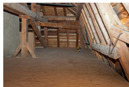
Eine Isolation der Aussenhülle war aus Gründen des Denkmalschutzes nicht möglich und eine Isolation von innen wäre baulich extrem schwierig und finanziell zu aufwendig gewesen. Deshalb erfolgte die Wärmedämmung über den Estrichboden.
