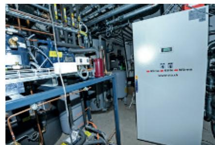
Der Technikraum vorher und nachher. Das Bild links zeigt den Raum, in dem früher der Ölbrenner und die Hochdruckpumpe für das Wasser untergebracht waren. Heute findet sich dort die für die Luft-Wasser-Wärmepumpe notwendig Technik.
