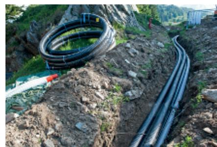
Montage des Aussenregisters für die Luft-Wasser-Wärmepumpe hinter dem Chalet Cassel (links) und die Zuleitungen für die Wärmepumpe in der Villa Cassel (rechts).
